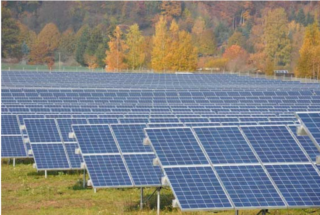
Circa 8 Ha di una ex discarica di rifiuti urbani, con una potenza di 1.26-2.14 MWh capaci di fornire fino a 550 unità abitative, poste ad una distanza di appena 160 m.
