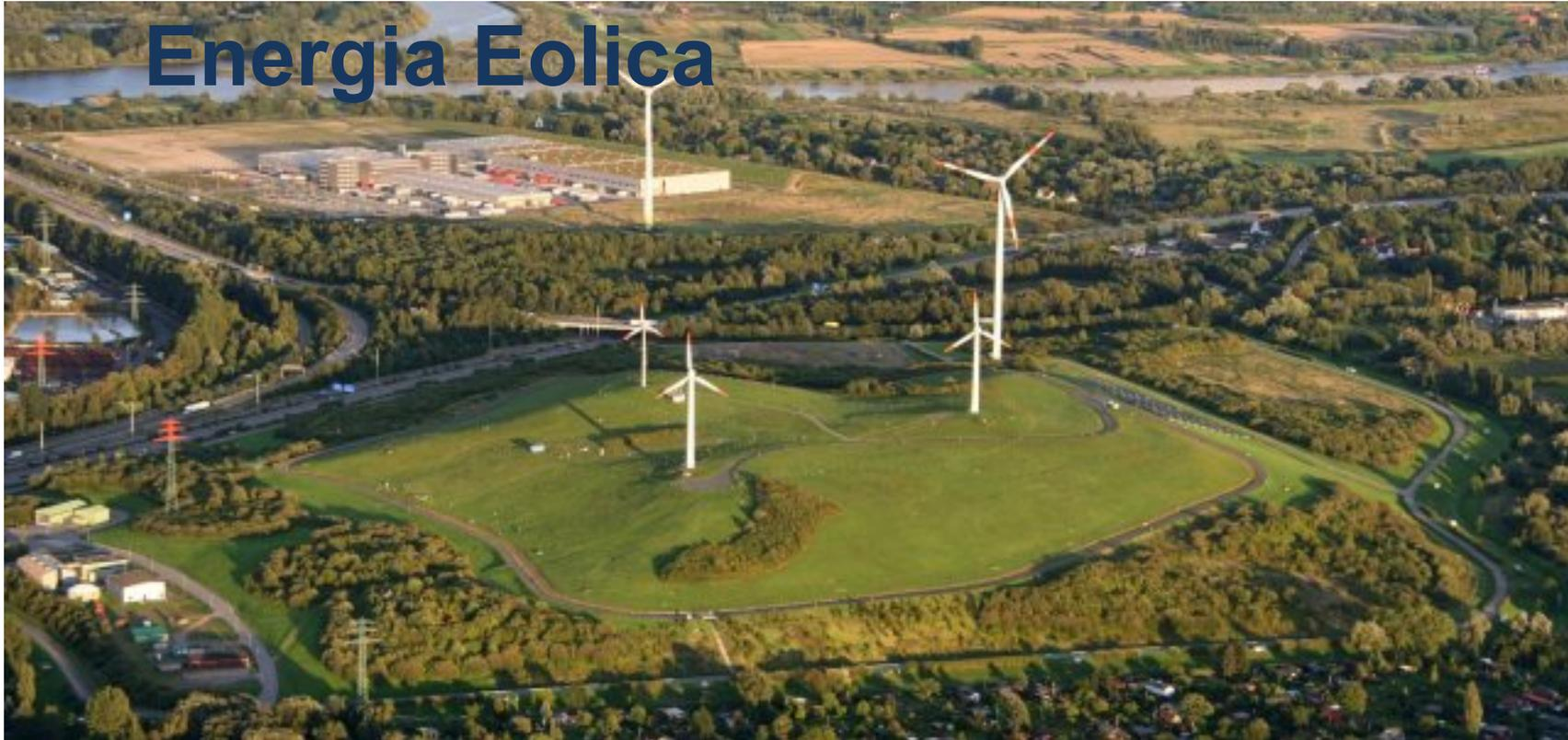
La prima turbina installata nel 1992. Altre tre più piccole nel 2004. Con diametro di 104 m, intercettano il vento in un'area di 8.500 mq.
